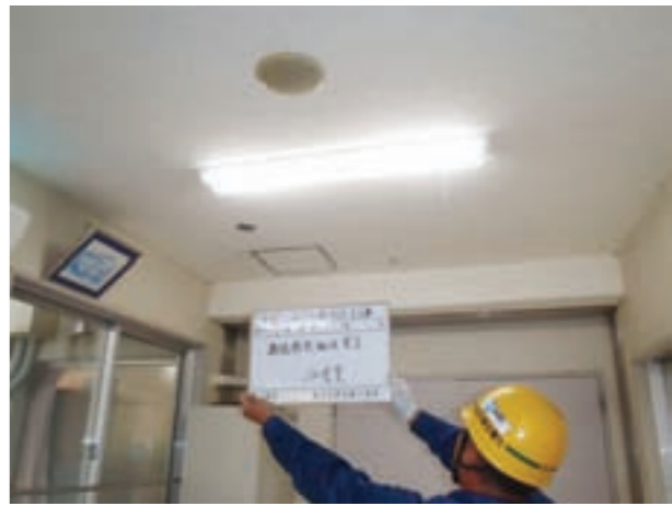
照明器具の取付
